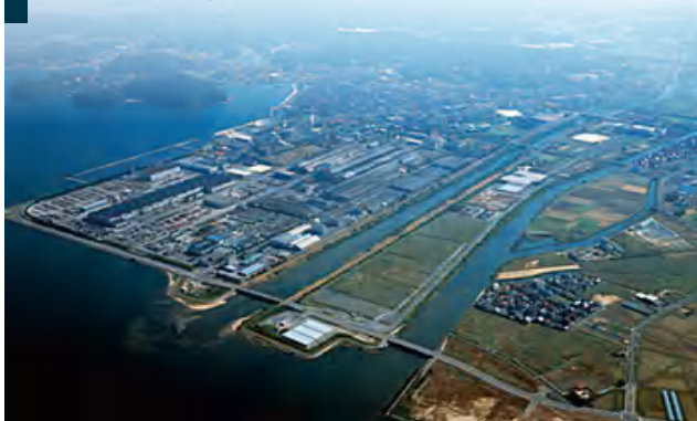
日本安来工厂 Anlai Factory, Japan
